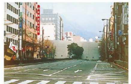
阪神・淡路大震災時に建物が倒壊し、道路が完全に塞がれた事例写真です。
